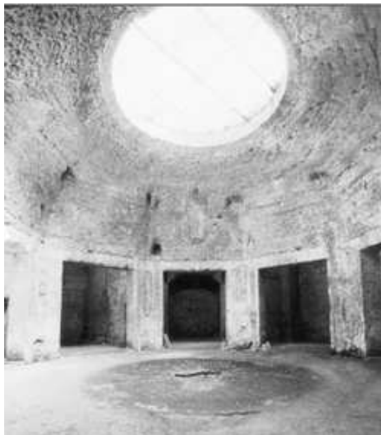
Voûte en béton de la Domus Aurea de Néron à Rome. (1 er siècle)
